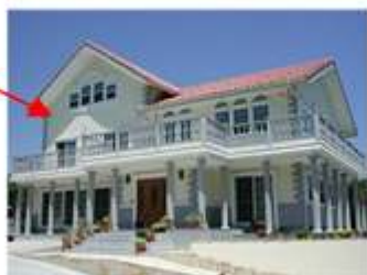
住宅への断熱材使用例
